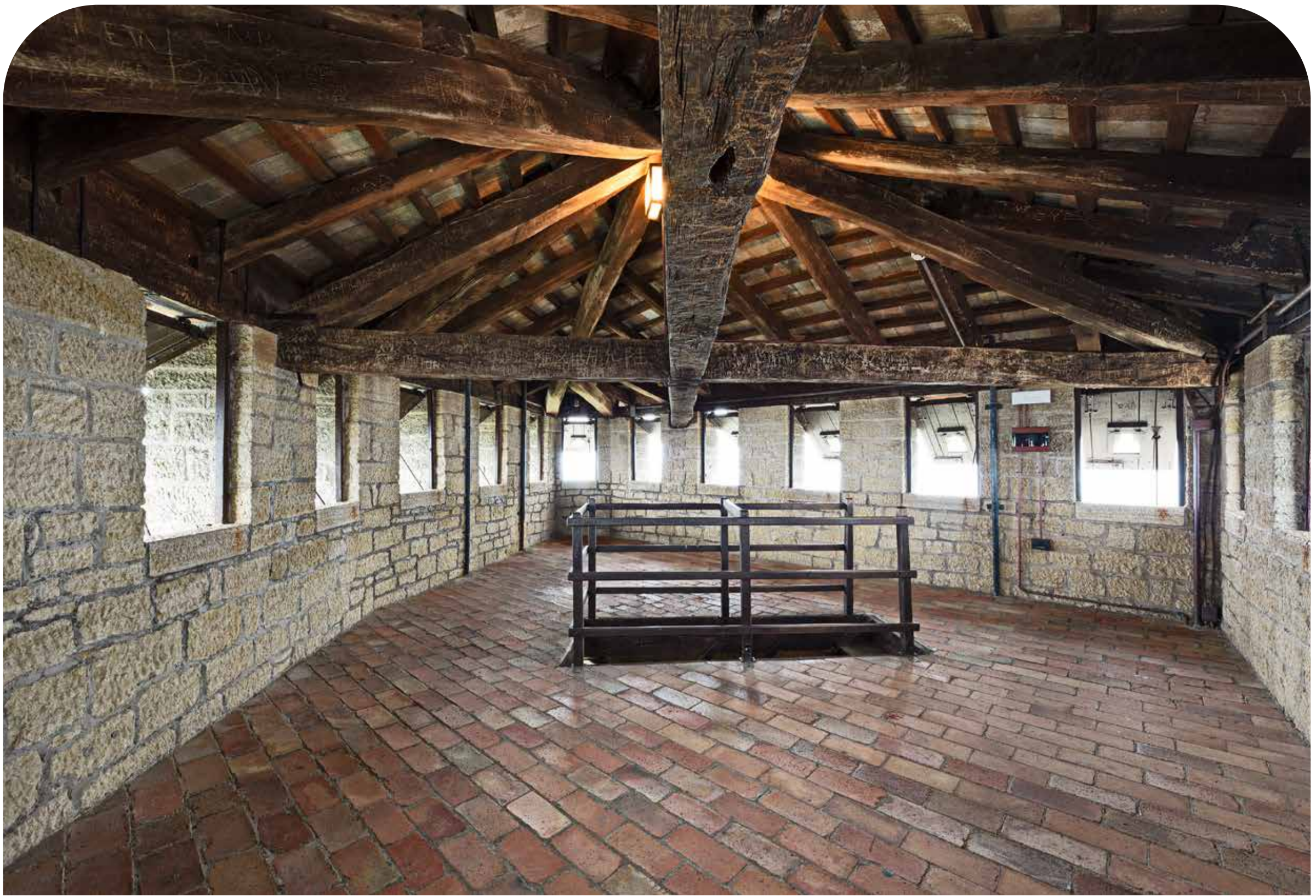
Seconda Torre, sottotetto
